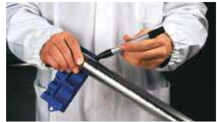
3 Marquage de la profondeur d'emboîtement
